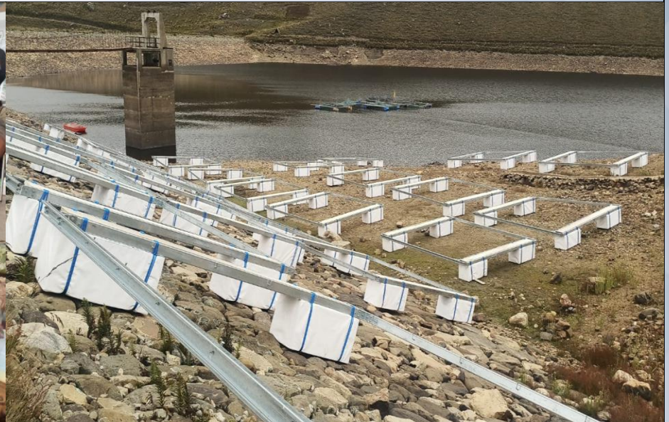
INSTALACIÓN DE JAULAS FLOTANTES AGUIRRE
