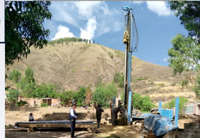
Perforación pozo en Chimboco Alto Convenio GADC - GAMS
